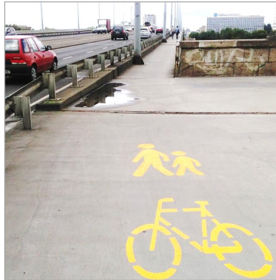
25. ábra: Nem előírás szerinti átvezetés hídműtárgy szűkületében (Budapest Petőfi híd)
