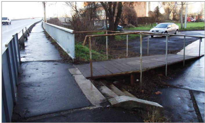
23.a-b. ábra: A 32. sz. főút vasúti felüljárója és keleti hídfője
