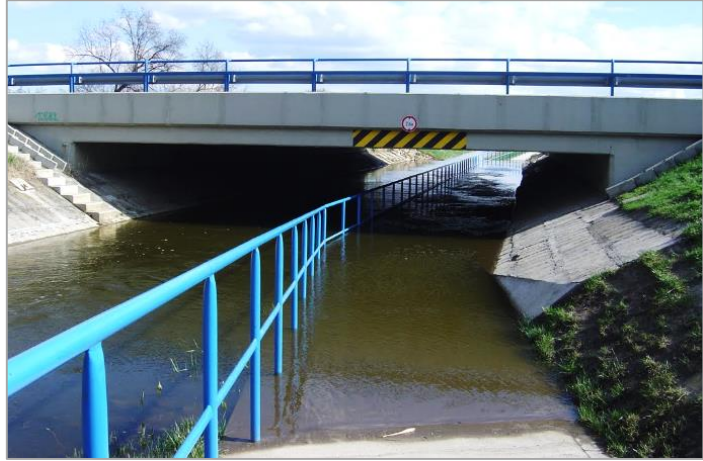
31. ábra: Példa időszakos műtárgy alatti kerékpáros átvezetésre (Kisfalud M7 autópálya)
