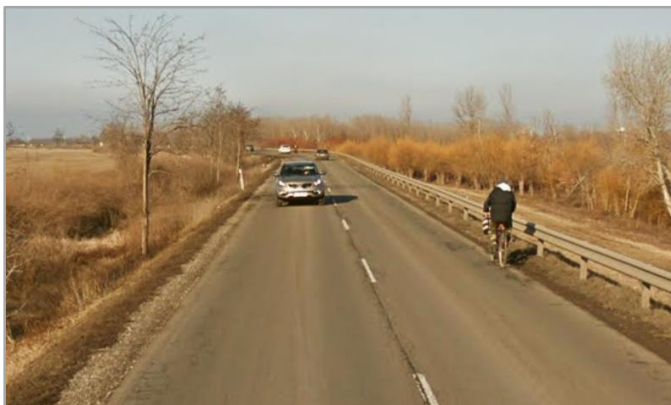
10. ábra: A 4625 j. összekötő út töltésen vezetett szakasza
